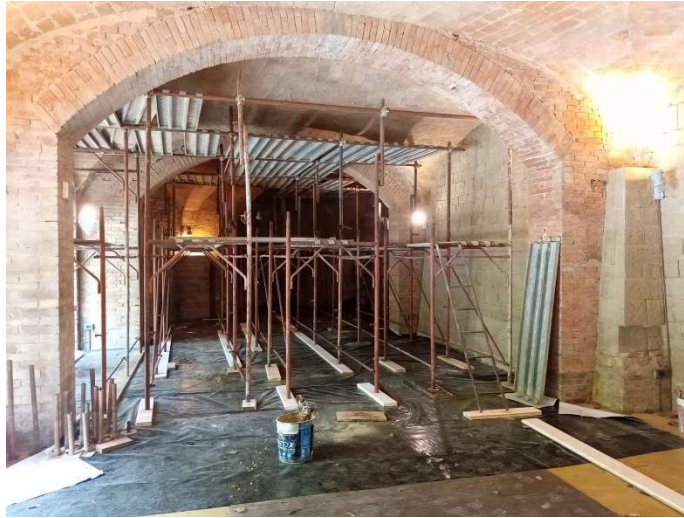
PUNTELLAZIONI E PONTEGGIO INTERNO
