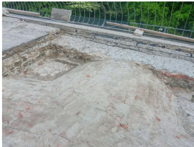
SVUOTAMENTO RINFIANCHI VOLTE E PULIZIA
