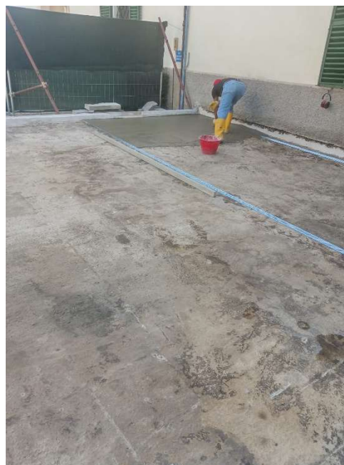
CONSOLIDAMENTO SOLAI IN LATEROCEMENTO
