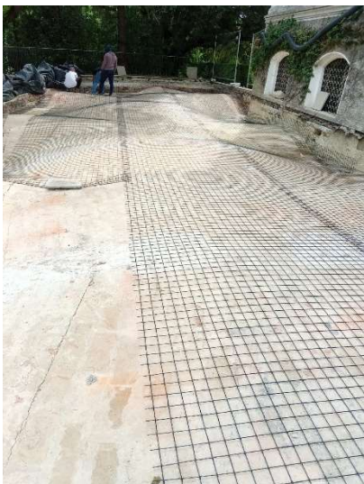
CONSOLIDAMENTO VOLTE -RETI BASALTICHE
