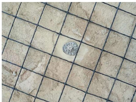
PRIMER E PIASTRINI DI ANCORAGGIO CON RESINA
